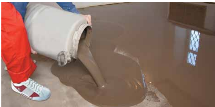
Нанесение самовыравнивающейся смеси на подготовленное основание
