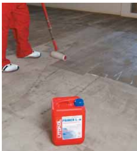
Нанесение грунтовки на основание для последующего нанесения LITOLIV S%
